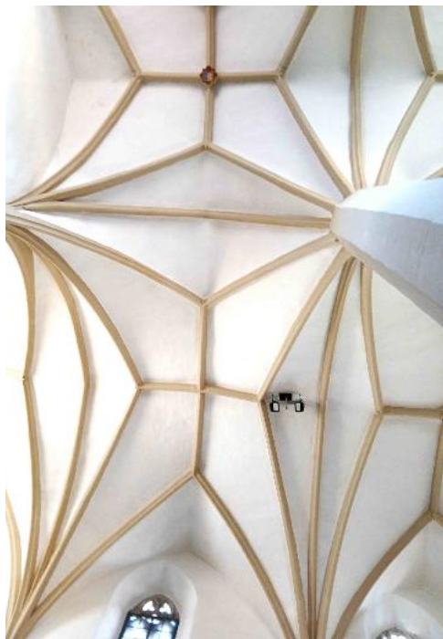
Pohled na strop
